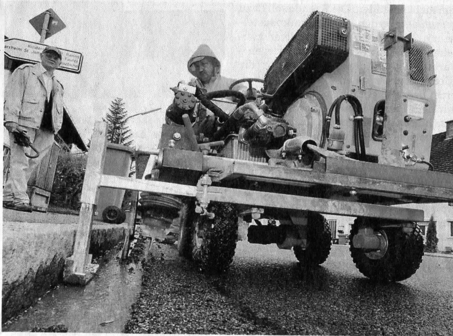
Noch werden letzte Arbeiten an der FFB 17 in Emmering erledigt. Doch offiziell wurde die Straße schon am Dienstag für den Verkehr freigegeben. Foto: Reger
