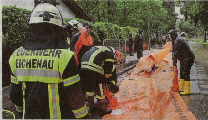
Sorgenkind Starzelbach: Der mobile Schlauchdamm Beaver gehört zu den Schutzmaßnahmen. ARCHIV: PETER WEBER
